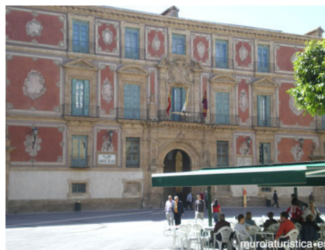
Fachada del Palacio Episcopal de Murcia
